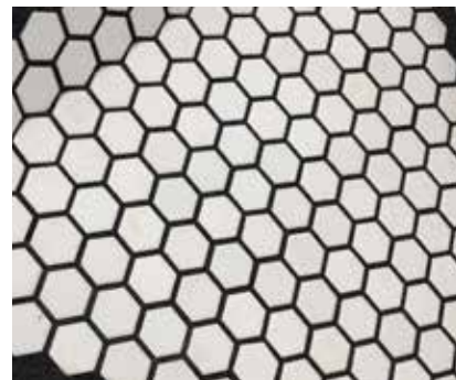
Verfugen von Aluminiumoxidfliesen
