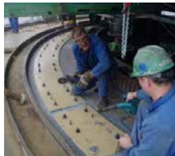
Beschichtung durch Einspritzen
