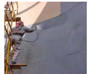
Auskleidung von Tanks
