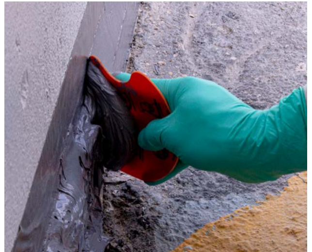
Verwendung zur Sanierung beschädigter Fugen im Eindämmbereich
