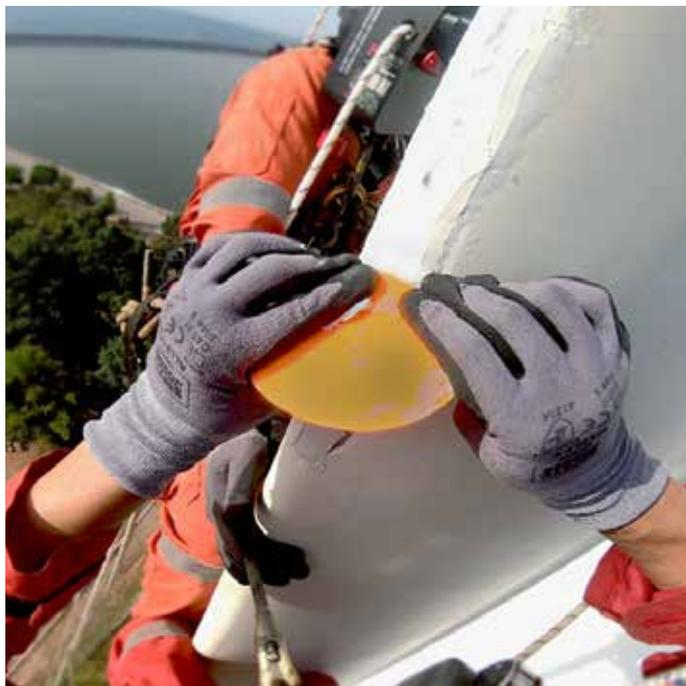
Belzona 5711 ist ein hochleistungsfähiges, leicht aufzutragendes System, das speziell für die Reparatur von Erosions- und Schlagschäden an den Vorderkanten der Rotorblätter von Windkraftanlagen entwickelt wurde.
