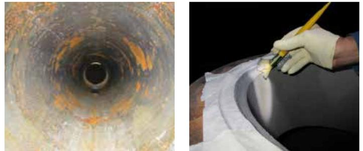
Hochtemperaturbehälter mit starken Korrosionsschäden Durch Lochfraß geschädigte und mit Belzona 1511 aufgearbeitete Oberfläche
