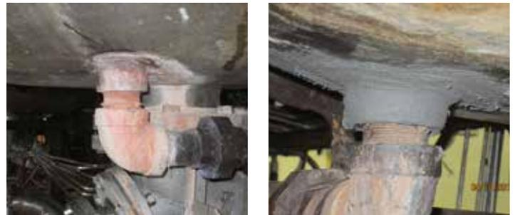
Prozessbehälter mit durch Korrosion perforierter Schweißnaht Zur langfristigen Reparatur der Löcher wurde Belzona 1511 eingesetzt.
