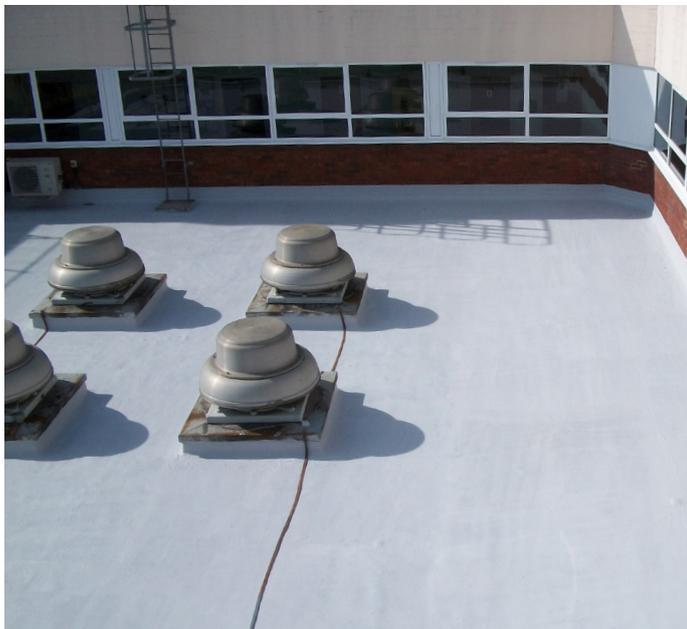
Belzona 3111 (Flexible Membrane) ist eine einkomponentige, lösungsmittelfreie, mikroporöse Beschichtung zur langfristigen Reparatur und zum Schutz aller Arten von Dächern, Tanksockeln und anderen Konstruktionen.
