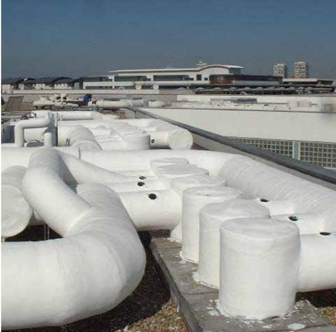
Belzona 3211 (Lagseal) ist eine einkomponentige, mikroporöse Beschichtung auf Wasserbasis zum Abdichten und für den Langzeitschutz aller Arten von Wärmedämmungen.
