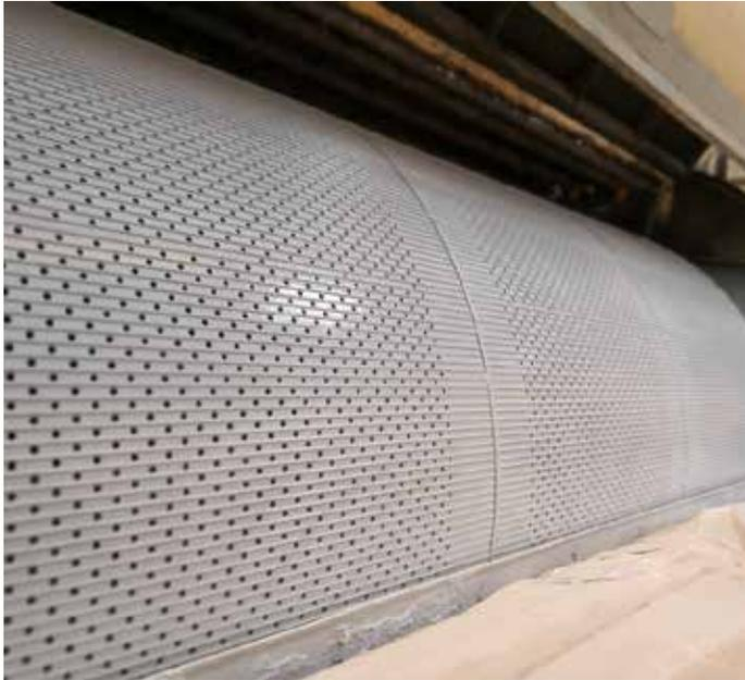
Belzona 5892 ist ein kostengünstiges Beschichtungssystem für den Korrosionsschutz von metallischen Oberflächen unter Eintauchbedingungen. Es schützt vor Beschädigungen durch wässrige Lösungen und Kohlenwasserstoffsysteme bei Temperaturen bis zu 95 °C.
