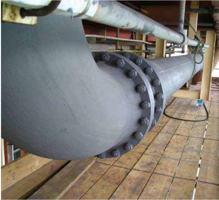
Belzona 5841 ist eine Zweikomponenten-Sperrbeschichtung zum Schutz von metallischen Oberflächen.
