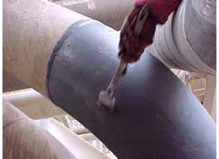
Korrosionsschutz von Rohren mit Belzona 5841
