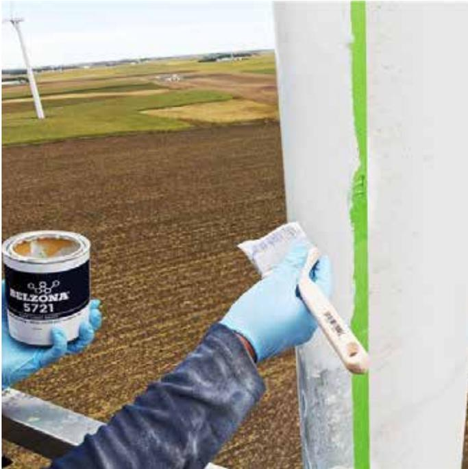
Belzona 5721 ist eine 2-Komponenten-Hochleistungsbeschichtung, die speziell für den Schutz der Vorderkante von Windturbinen-Rotorblättern vor Erosion und Schlagschäden entwickelt wurde.
