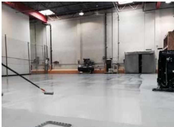
Belzona 5233 kann einfach mit Pinsel oder Rolle von Hand aufgetragen werden.
