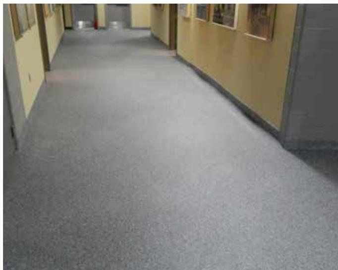
Es wird als Deckschicht auf Belzona 5231 mit lokal beschafftem Flockenmaterial verwendet.
