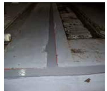
Reparatur mit Belzona 4521
