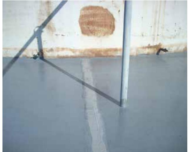
Verwendung zur Sanierung beschädigter Fugen im Eindämmbereich
