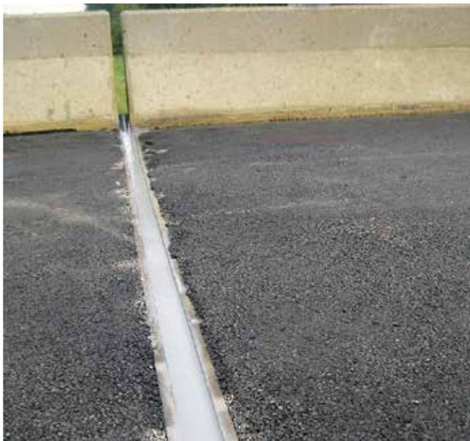
Belzona 4521 (Magma-Flex Fluid) ist ein lösungsmittelfreier Zweikomponenten-Werkstoff, der zur wirksamen Abdichtung von Bau- und Dehnfugen entwickelt wurde.
