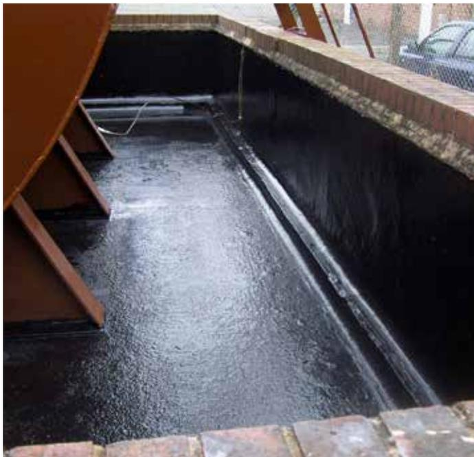
Belzona 4351 ist eine elektrostatisch ableitende Zweikomponentenbeschichtung, mit der sich elektrostatische Aufladungen in explosionsgefährdeten Bereichen ableiten lassen. Aufgrund seiner hervorragenden elektrostatisch ableitenden Eigenschaften trägt Belzona 4351 dazu bei, elektrostatische Aufladungen als Zündquelle bei der Lagerung von brennbaren Materialien auszuschließen.
