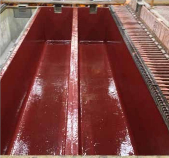
Belzona 4341 (Magma CR4) ist eine Zweikomponenten-Sperrbeschichtung zum Schutz von Oberflächen, die einer Beschädigung durch Chemikalien ausgesetzt sind. Das Produkt ist gegenüber anorganischen Säuren wie Schwefel- und Salzsäure bis zu 90 °C beständig.
