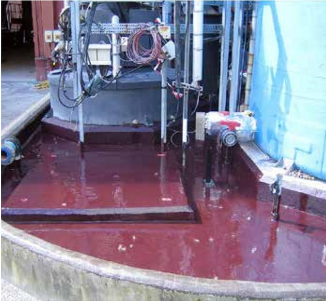
Belzona 4331 (Magma CR3) ist eine Zweikomponenten-Sperrbeschichtung zum Schutz von Oberflächen, die einer Beschädigung durch Chemikalien ausgesetzt sind. Belzona 4331 wurde so formuliert, dass eine optimale Beständigkeit gegen heiße organische Säuren bis 90 °C gewährleistet ist.
