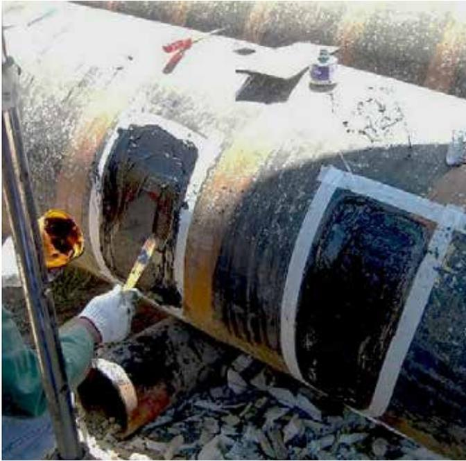
Belzona 2311 (SR Elastomer) ist ein zweikomponentiger Verbundwerkstoff aus elastomeren Polymeren zur Reparatur und Wiederherstellung von Gummikomponenten.
