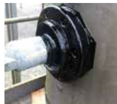
Leckabdichtung am Transformator
