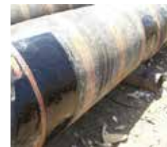
Reparatur des schwimmenden Schlauchs
