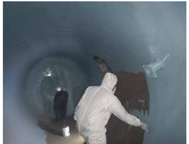
Belzona 1391T wird manuell aufgetragen
