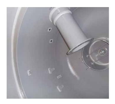
Belzona 1331 ist ein Zweikomponenten-Beschichtungssystem für den Erosions- und Korrosionsschutz von Anlagen, die unter kontinuierlichem Eintauchen bei Temperaturen bis 50 °C betrieben werden.
