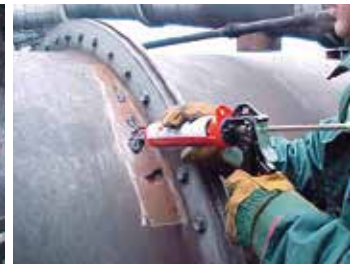
Auffüllen von Korrosionsnarben
