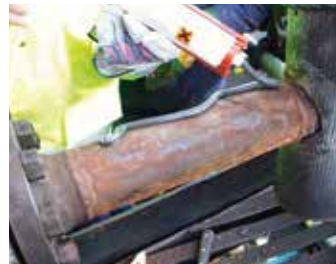
Verkleben von Blechen
