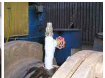
Leckabdichtung an Rohrleitungen
